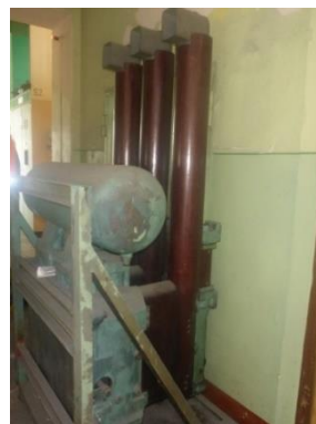
Zdj. 4. Włłącznik powietrzny zdemontowany z pola rozdzielni 6 kV na ECI
