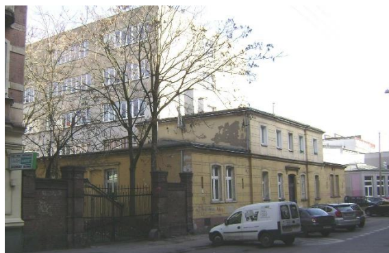
Rys. 6. Budynek „Cantor” i brama wjazdowa do dawnej fabryki oleju przy Worcella 18
