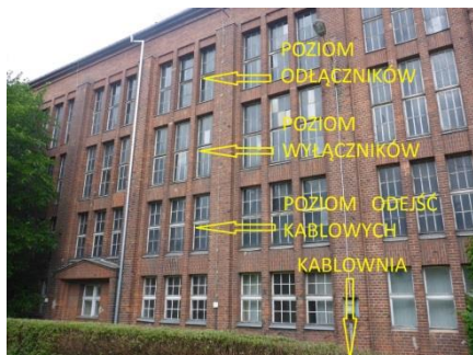
Zdj. 12. Budynek rozdzielni 6 kV na ECI
