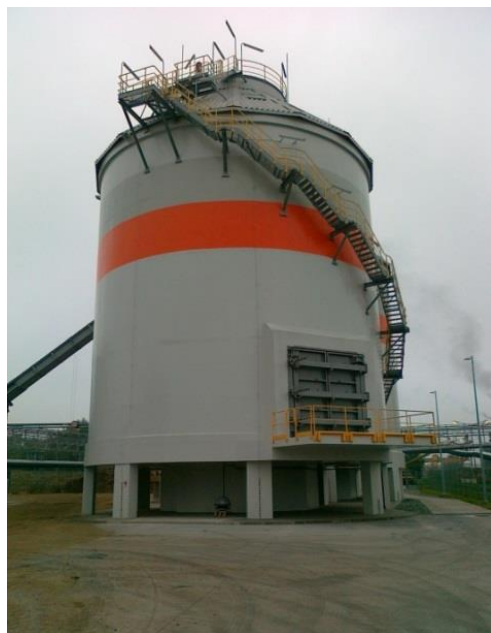
Rys. 2. Silos biomasy w EC Czechnica
