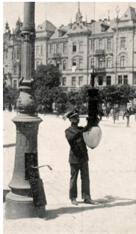
Fot. 12. Lampa łukowa, zakładanie węgla (źródło: J. Tomicki. Ze statystyki miejskich zakładów elektrycznych we Lwowie, Lwów - 1912.)
