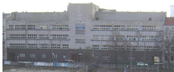
Rys. 9. Fasada budynku przy ul. Hauke Bosaka 21, widok współczesny
