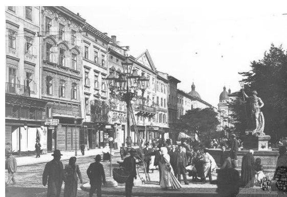
Fot. 5-6. Gazowe latarnie na ulicach Lwowa z drabinkami dla lampiarzy, zapalających światło (źródło: kartka pocztowa, Wikipedia)
