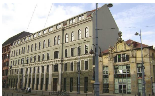
Rys. 8. Druga siedziba szkoły przy pl. Teatralnym 6/7. Obok budynek dawnej słodowni z XVI wieku przebudowanej na palarnię kawy w 1899.
